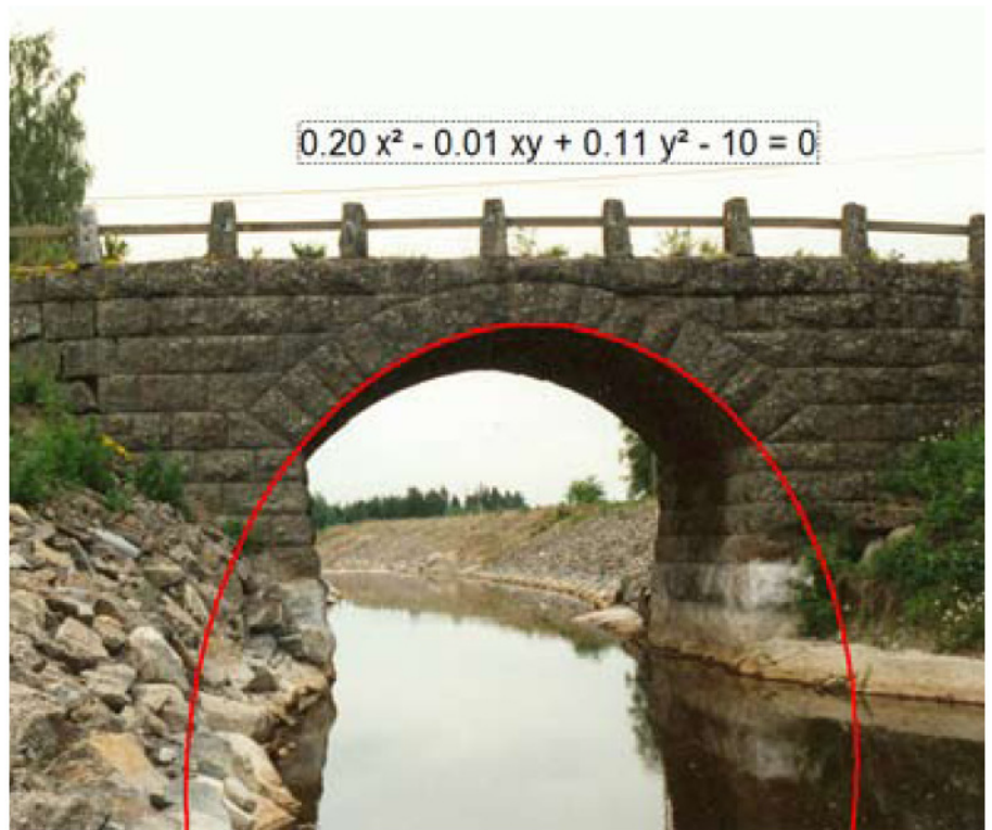
Kuva 3 Nansion silta Laitilan Kodjalassa. Cabrin mielestä siltakaari on elliptinen. (Kuva kirjoittajan.)
